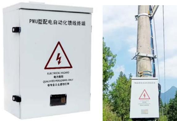
图 3-2 PMU 型 FTU 终端
