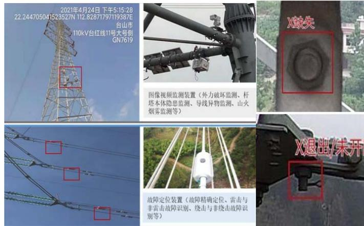
图 2-7 摄像头输电线路监测
