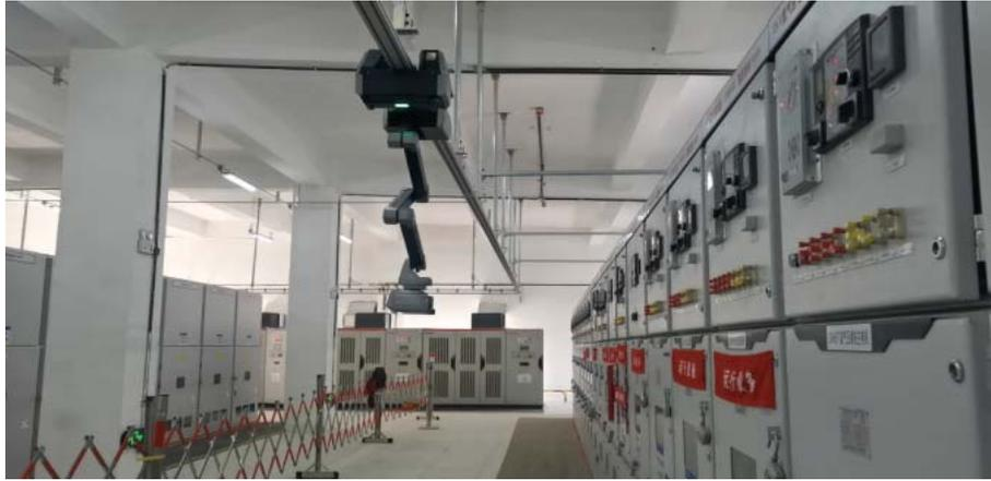
图 3-3 配电房巡检机器人
